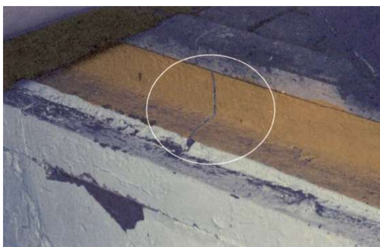
写真1-14 鉄道レールの損傷（兵庫県南部地震）
